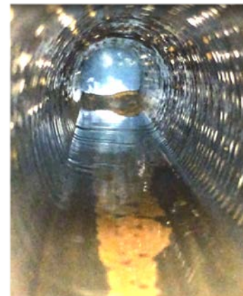
写真-4 管内部の集水状況(卵形管)
